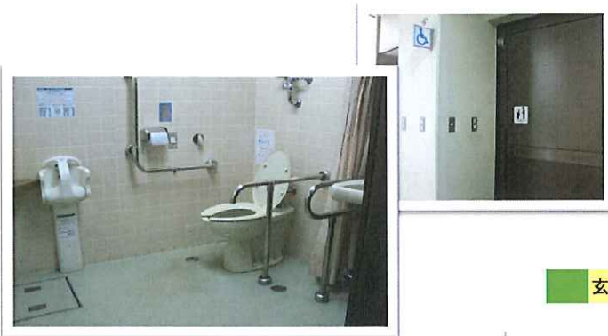
障がい者用のトイレを設置しています
