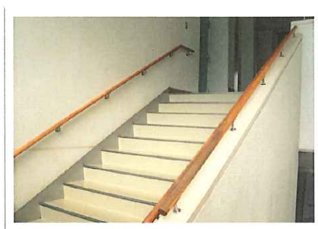
階段に手すりを設置しています
