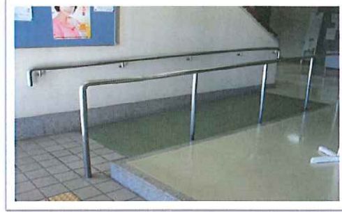
正面入り口にスロープを設置しています
