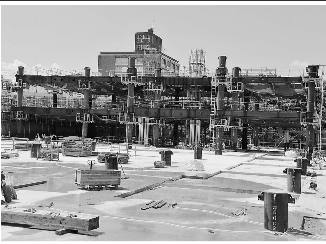
建設進む習志野市役所新市庁舎 (8月25日撮影)
